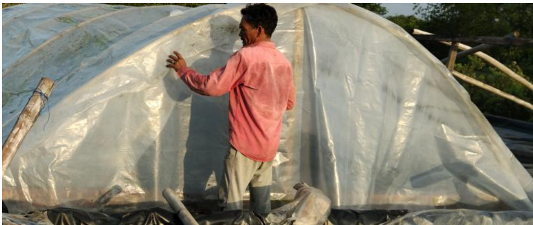
Gambar 3. Rumah Penguapan Yang Telah Dibangun Dengan Konstruksi Setengah Elips Pada Lokasi Petak Tambak Garam
