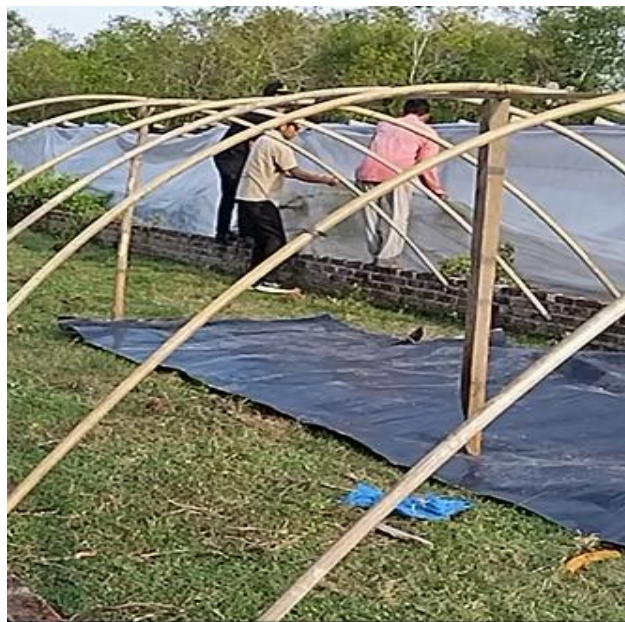
Gambar 2. Pembangunan Rangka Rumah Penguapan Dengan Konstruksi Setengah Elips
